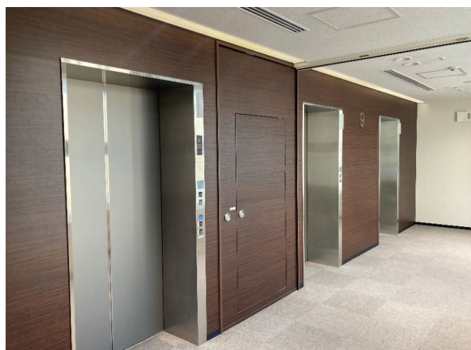
エレベーター
